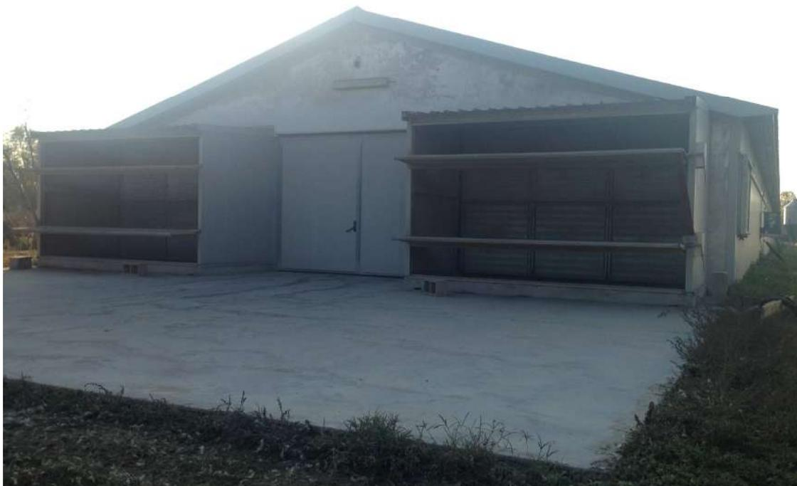
Figura 1 - Immagine della parte distale dei capannoni di stabulazione dotata del sistema di contenimento di polveri/odori
